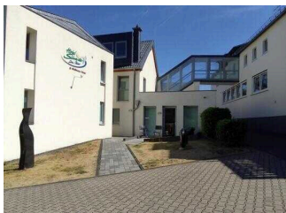
Weg vom Parkplatz am Nebengebäude zu den Eingängen zum Zimmer 31
