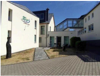
Eingang zum Nebengebäude
